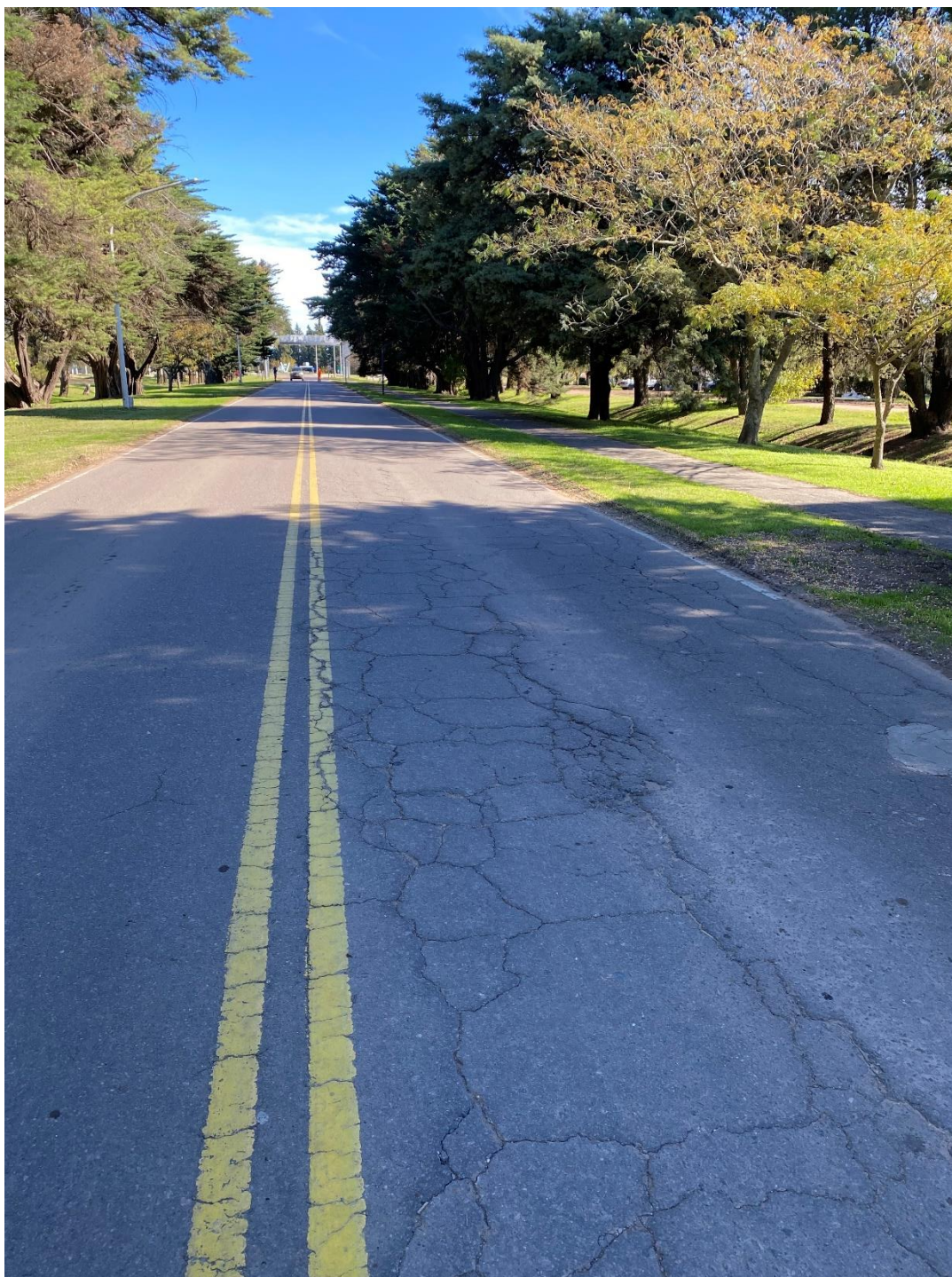
Ilustración 3: Ingreso a Henderson a repavimentar
