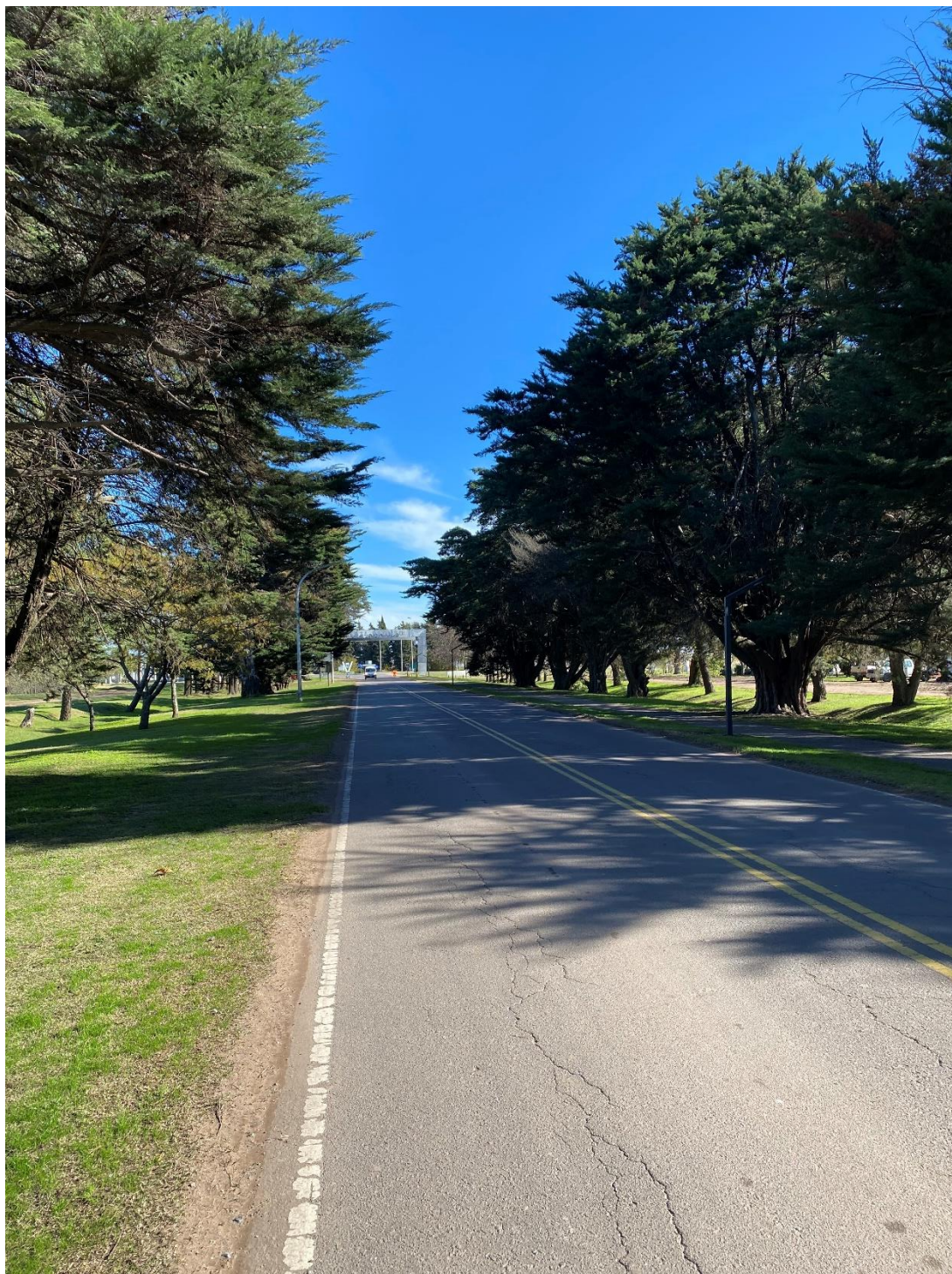
Ilustración 4: Ingreso a Henderson a repavimentar
